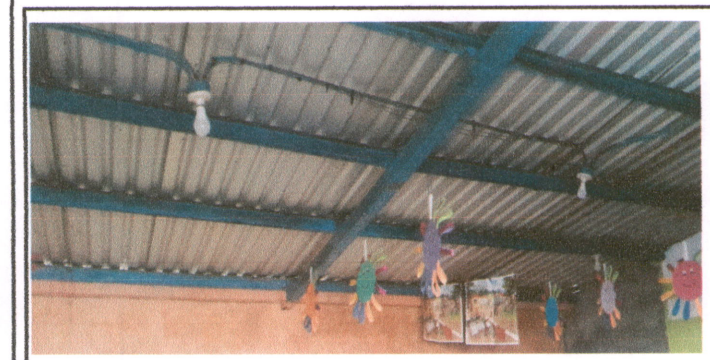
Foto 5: Reparación de sistema eléctrico
