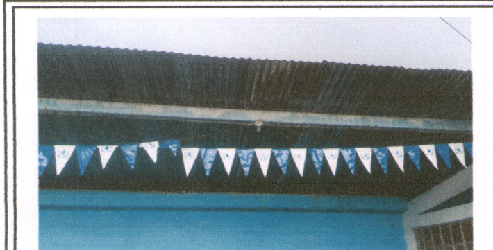
Foto 1: Sustrucción de lámina, por lámina troquelada aluzinc calibre 26, sustrucción de estructura de soporte de metal por metal
