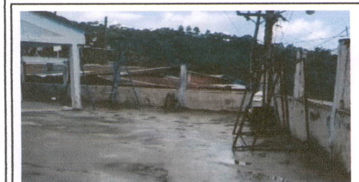
Foto 3: Reparación de muro perimetral de block
