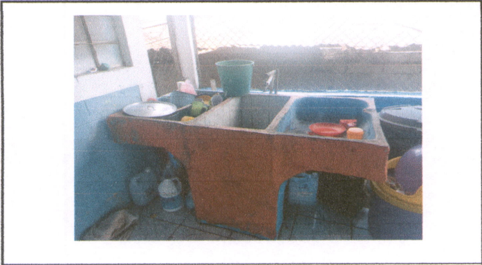
Foto 7: Sustrucción de pila de cemento de dos lavaderos
