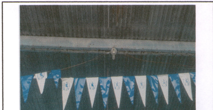
Foto 4: Reparación de sistema eléctrico
