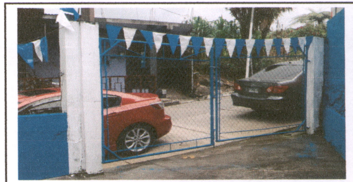
Foto 6: Fabricación e instalación de Portón de Metal de Ingreso
